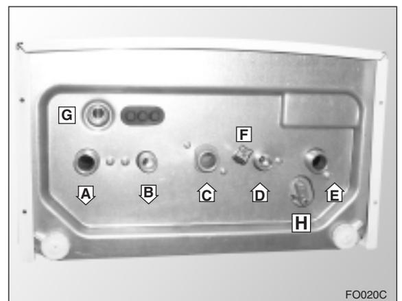
In figura sono rappresentati i raccordi per l'allacciamento idraulico e gas della caldaia. Verificare che la pressione massima di rete non superi i 6 bar; in caso contrario è necessario installare un riduttore di pressione.
